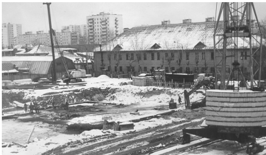
Начало строительства 101-го корпуса
